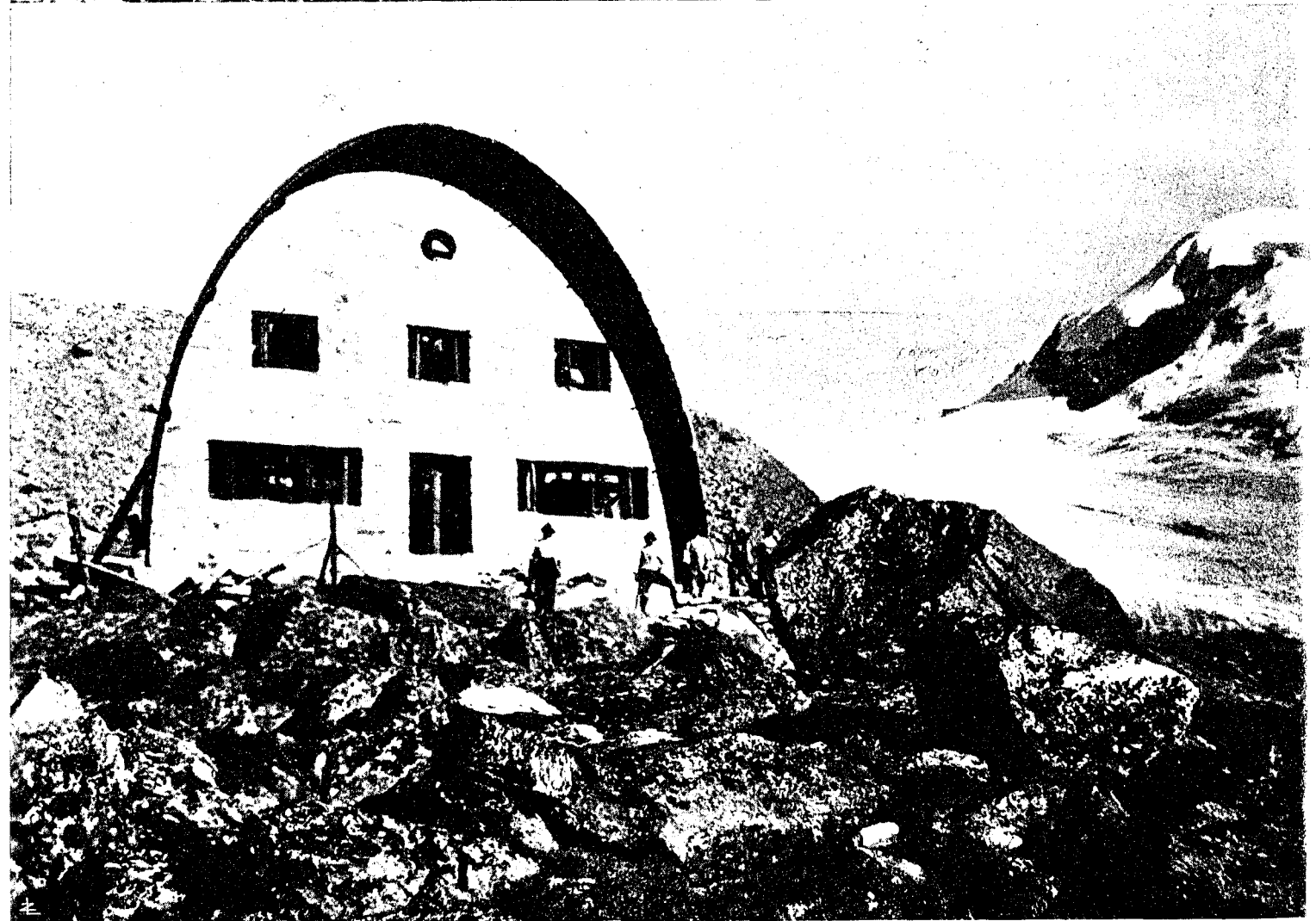
IL NUOVO RIFUGIO «VITTORIO EMANUELE II» al Gran Paradiso, m. 2765, della Sezione di Torino del C. A. I. (In costruzione; progetto Arch. Melis)
