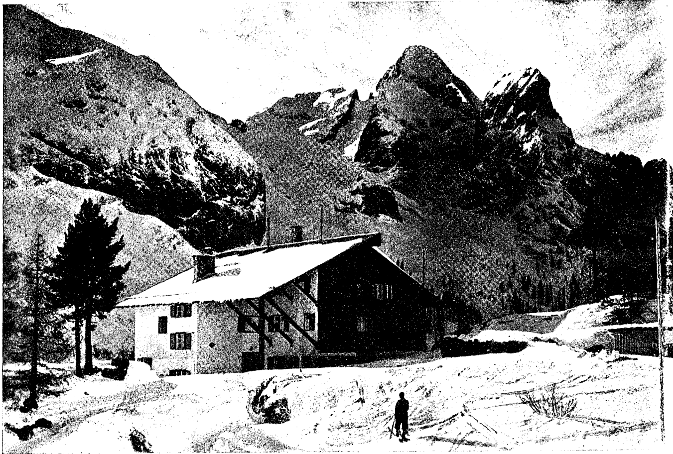
RIFUGIO - ALBERGO «MARMOLADA», m. 2042, della Sede Centrale del C. A. I.: prospetto Sud (progetto Ing. Giulio Apollonio)
