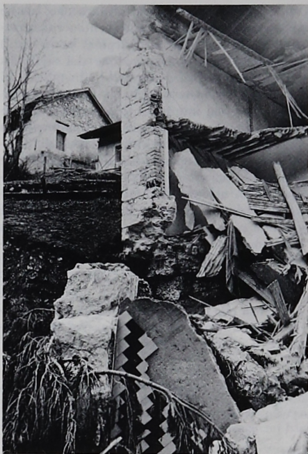
Abitazione distrutta per calamità a Gosaldo.
