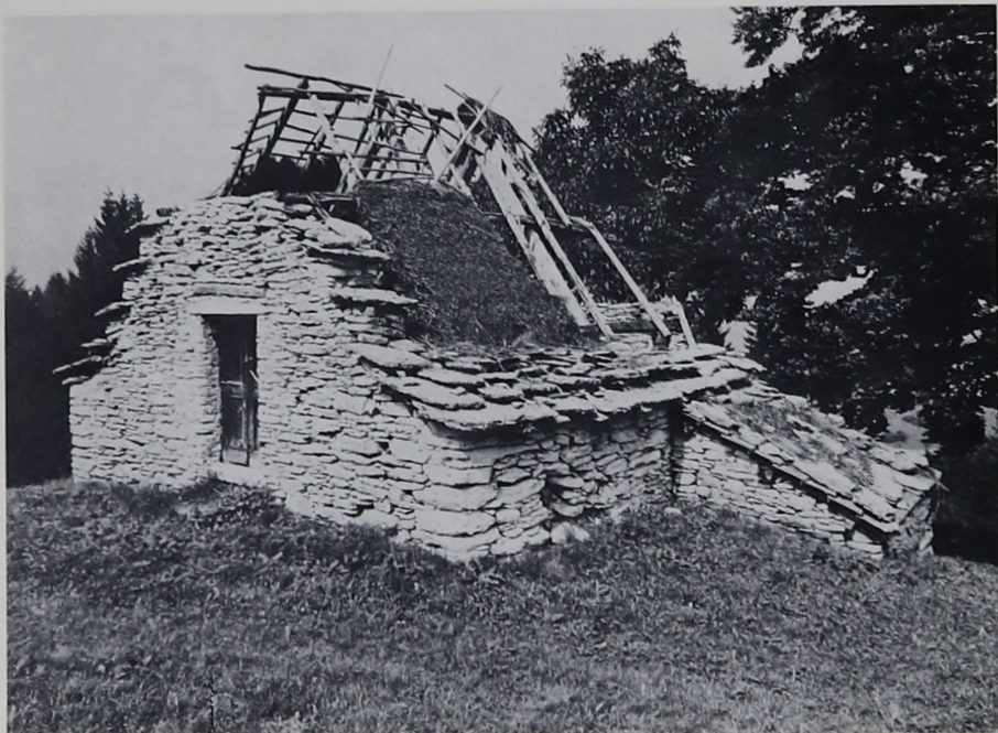
Stalla del complesso della foto 2. La copertura del tetto è realizzata con paglia. Si notano i caratteristici "gradini" che salgono simmetricamente al colmo del tetto. (Foto M. Maniscalchi)
