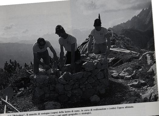
Sul "Belvedere". Il muretto di sostegno (sopra) della lastra di rame, in corso di realizzazione e (sotto) l'opera ultimata. Le frecce direzionali indicano con precisione i vari punti geografici e strategici.
