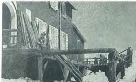
In alto: Il Rifugio Livrio con la «bussola» costruita all'entrata. In basso, a sinistra: Il terrazzo sfondato dalla neve; a destra: la nuova porta d'entrata al Rifugio attraverso la «bussola».
