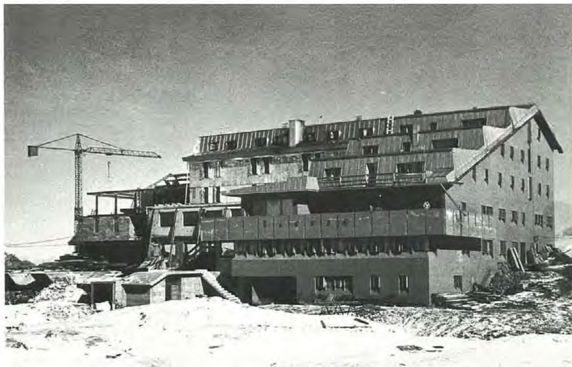
I lavori al Rifugio Livrio a fine ottobre (foto A. Gamba)
