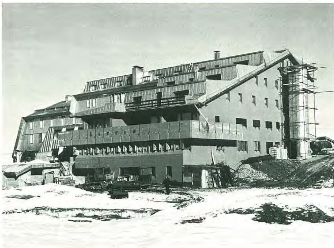
Lo stato dei lavori al Livrio nell'autunno del 1978 (foto G. B. Villa)
