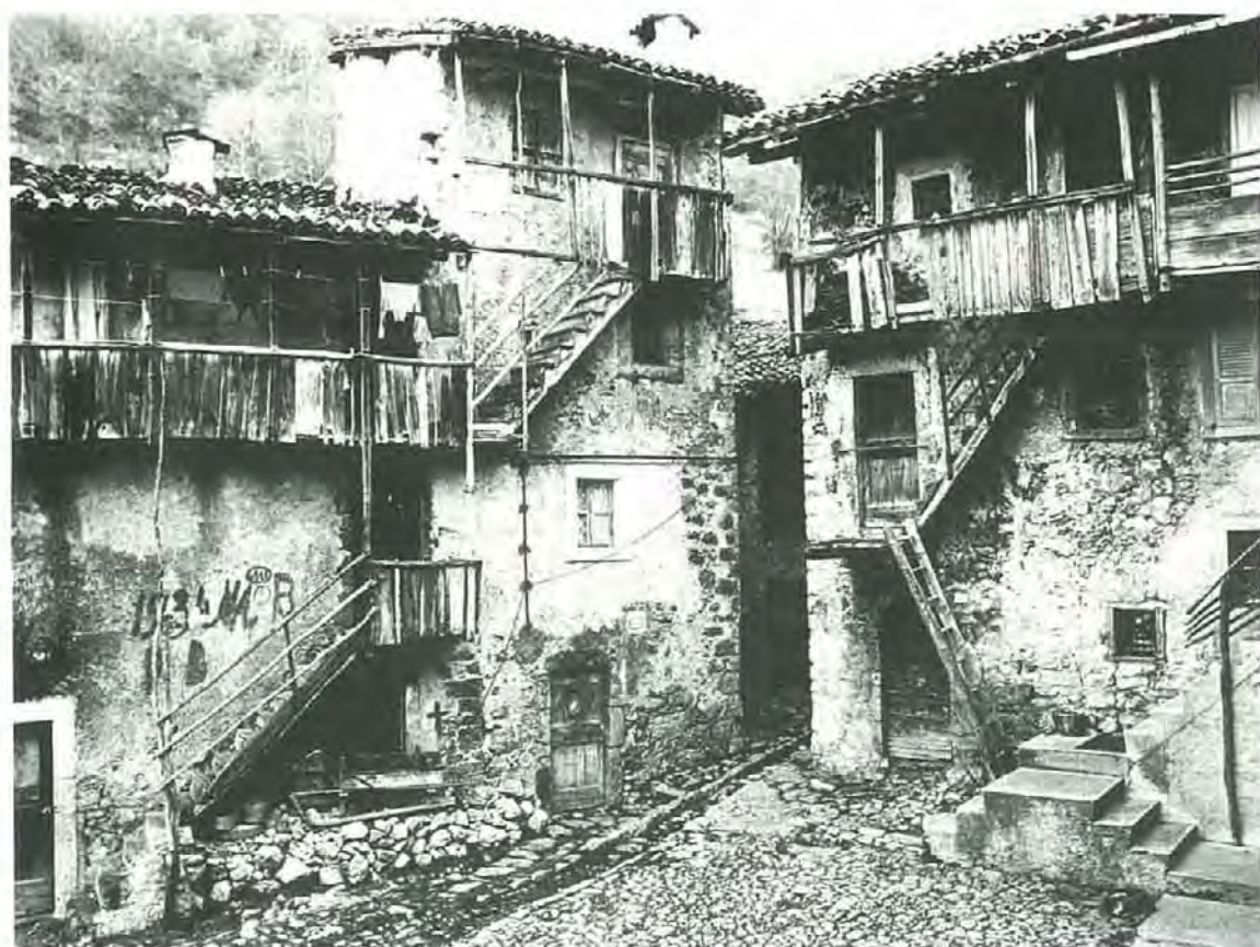
Scale in legno su edifici rustici a Catremerio (foto: M. Adovasio)
