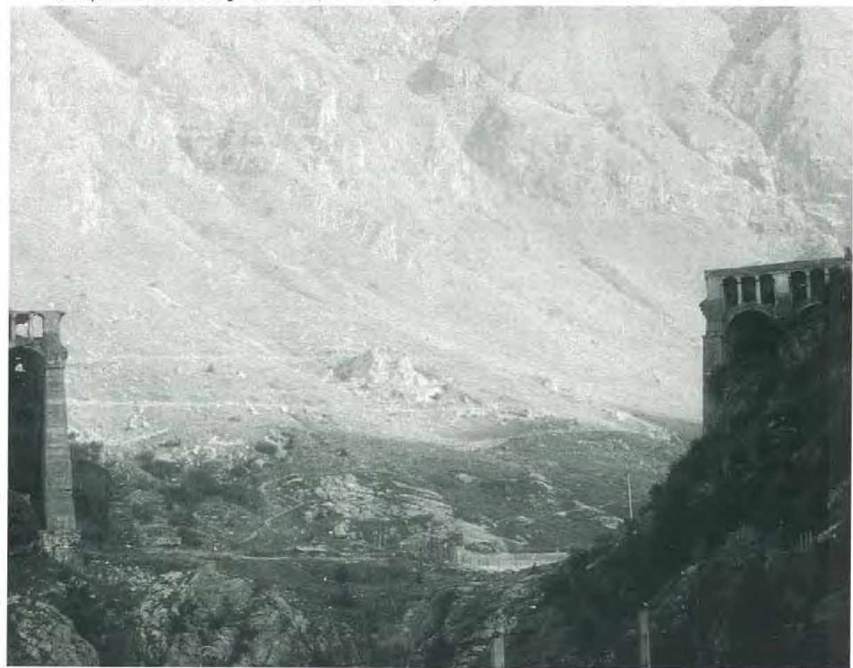
Gli imponenti resti della diga del Gleno (foto: P. Cortinovis)
