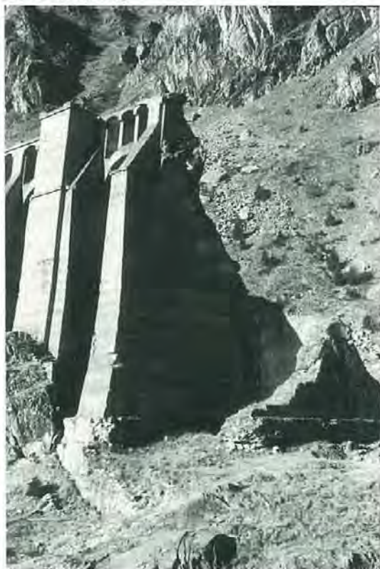
Il resto dei contrafforti della diga del Gleno (foto: P. Cortinovis)
