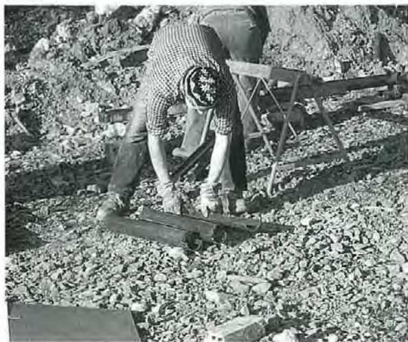
Sonda all'opera per l'estrazione della carota
