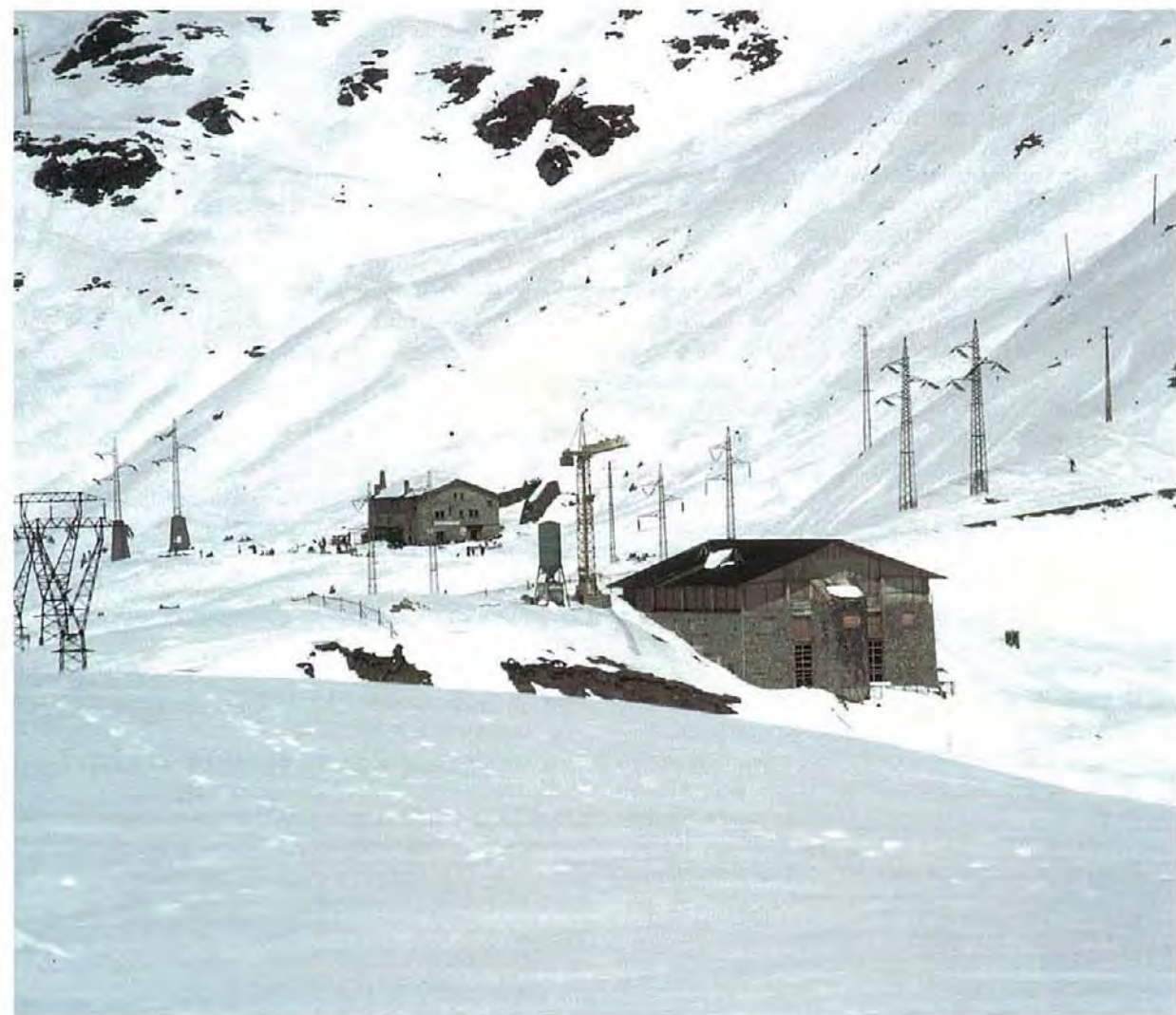
In secondo piano la storica cantoniera di San Marco, in primo piano il nuovo mastodontico rifugio-albergo (foto: R. Zonca)
