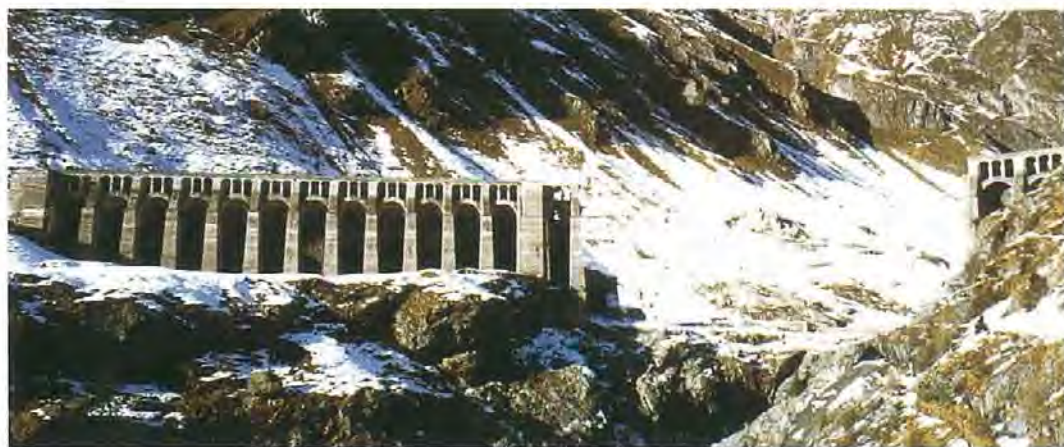
Immagine frontale della diga del Gleno (foto: R. Zonca)
