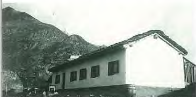
Il primo edificio del Rifugio Laghi Gemelli (foto: Arch. Sezione)
