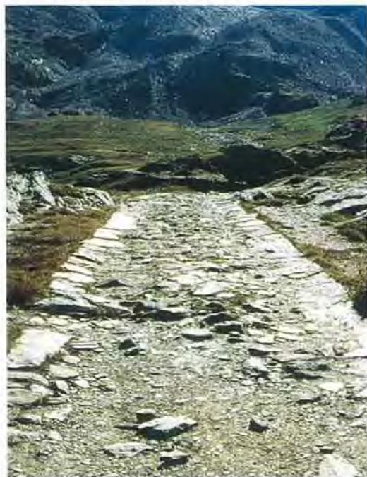
Particolare della cordonatura laterale di una strada militare (foto W. Belotti)
