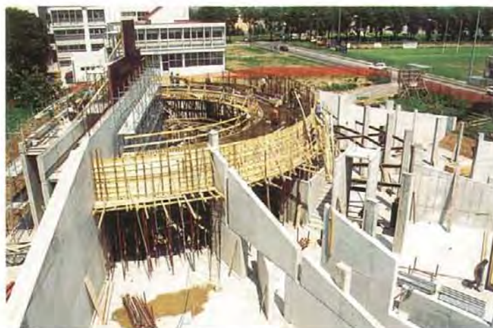
Palamonti: Avanzamento lavori al 30 maggio 2004 ( Nino Poloni )
