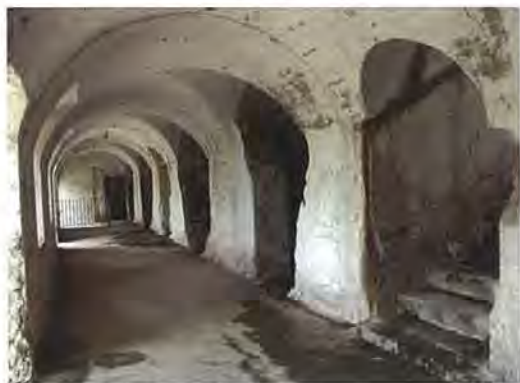
Corridoio della batteria del forte - foto: W. Belotti
