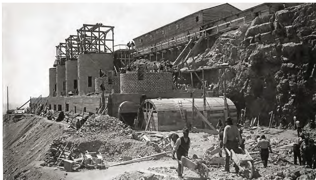
■ Cantiere Chaberton. (Foto: G. Rosa)
