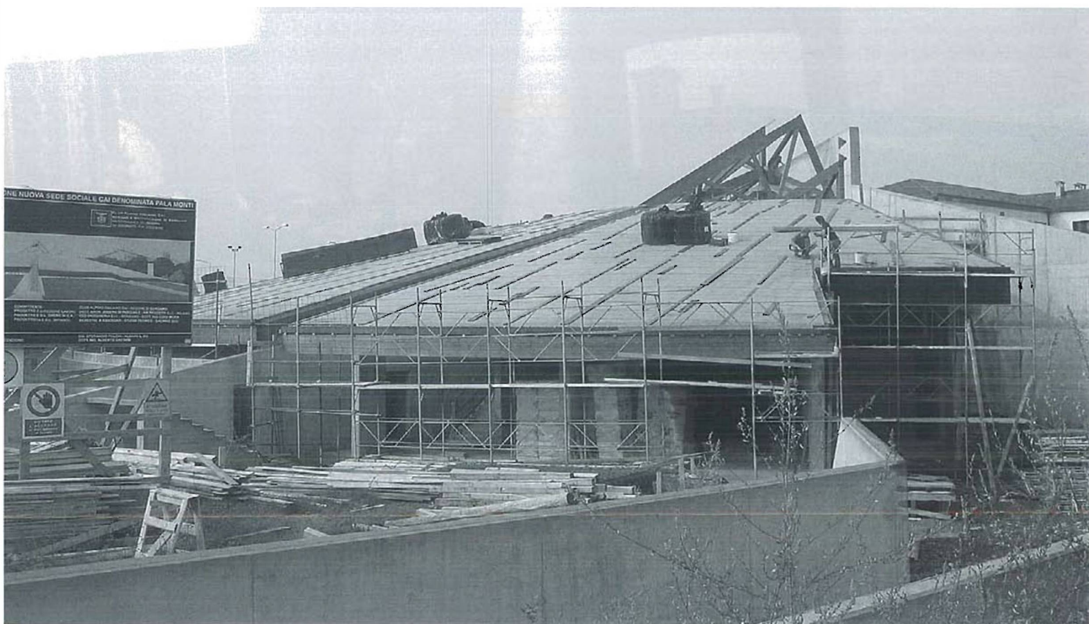
Palamonti: lo stato di avanzamento del cantiere a metà ottobre (foto Stefano Ghisalberti)
