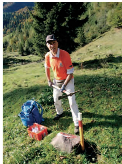
Lavori sistemazione della segnaletica
