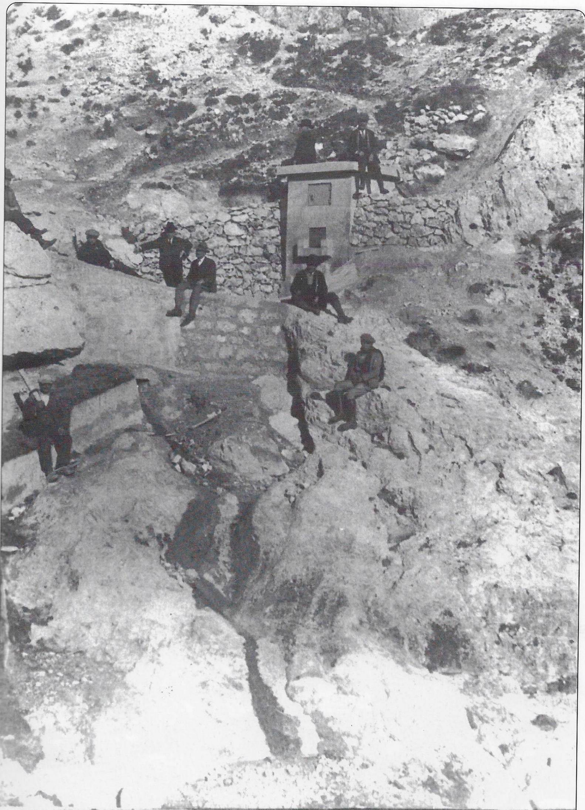
Acquedotto consorziale di Rionne
