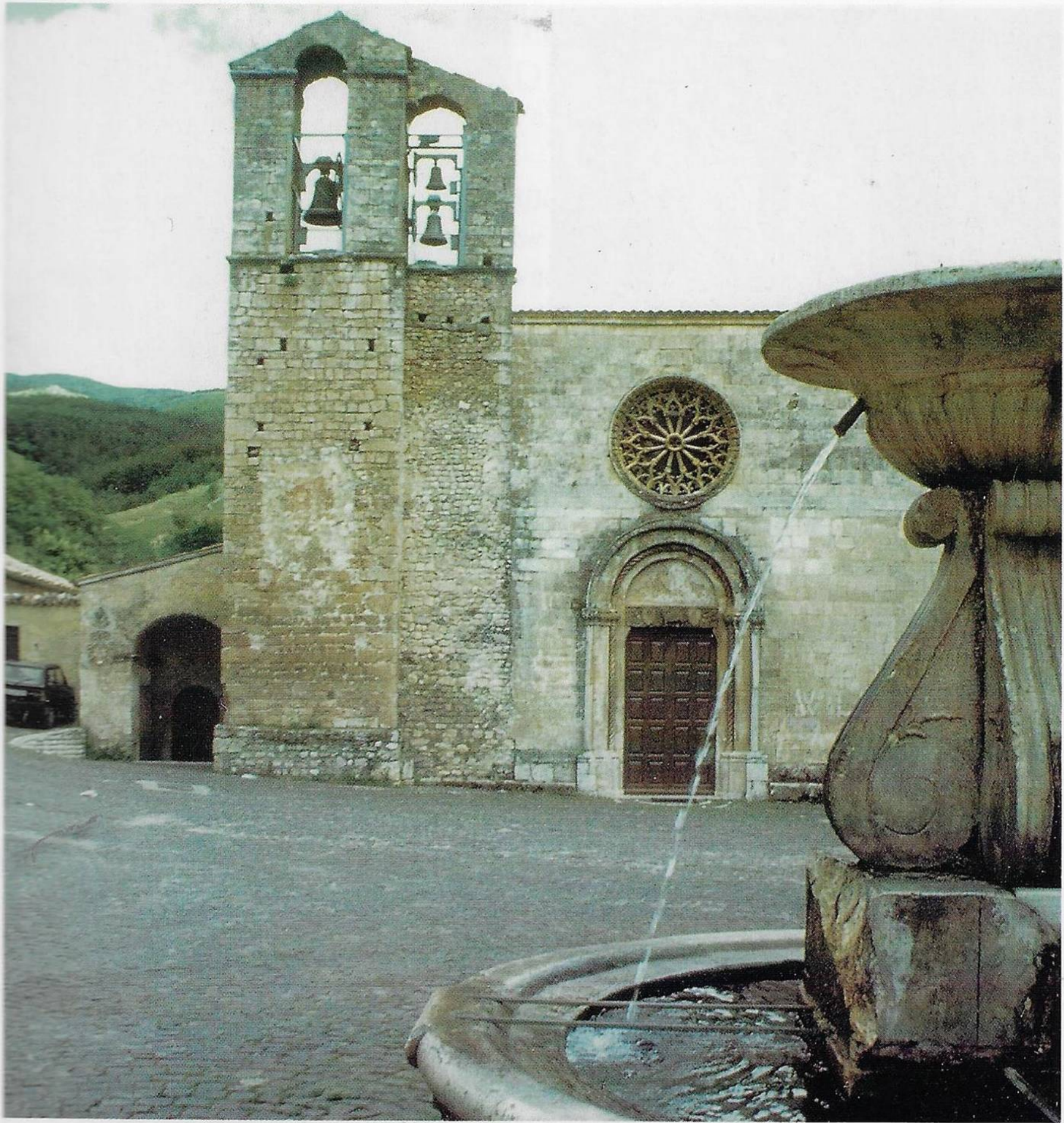
La facciata della ex abbazia di S. Maria Assunta ad Assergi. (Foto: B. Marconi)
