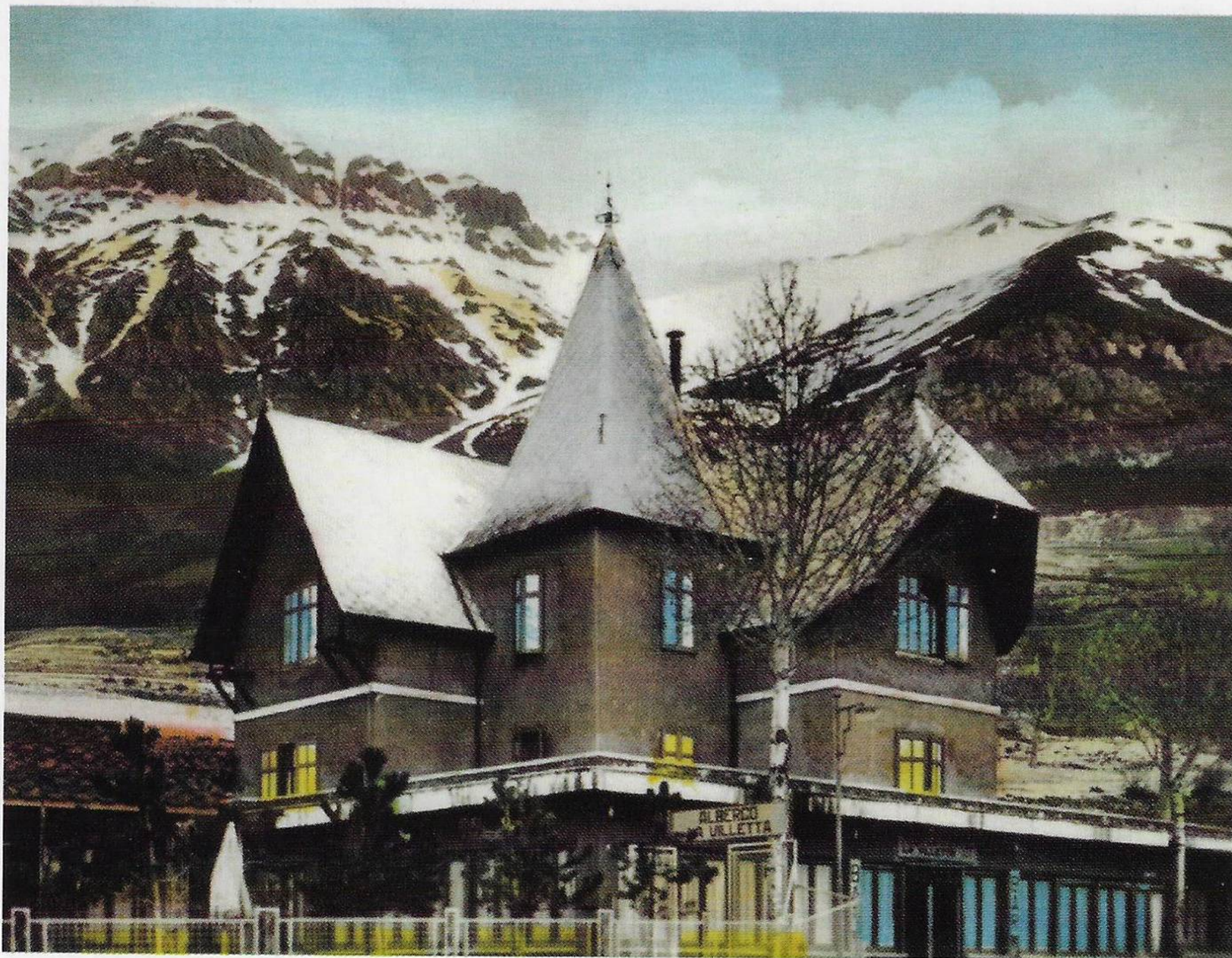
La villetta di Fonte Cerreto dove fu trasferito Mussolini prima di essere ospitato nell'albergo di Campo Imperatore.
