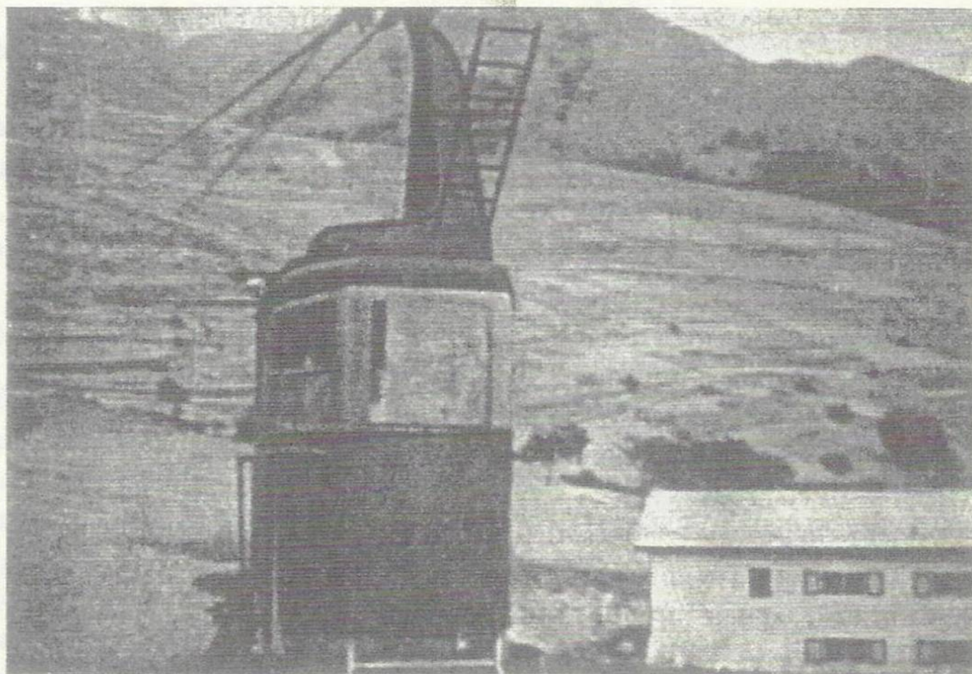
Fig. 1. — La funivia che in due balzi, superando un dislivello di 1100 metri cioè da 1100 a 2200 metri ha portato i congressisti dalla base, presso Assergi, a Campo Imperatore
