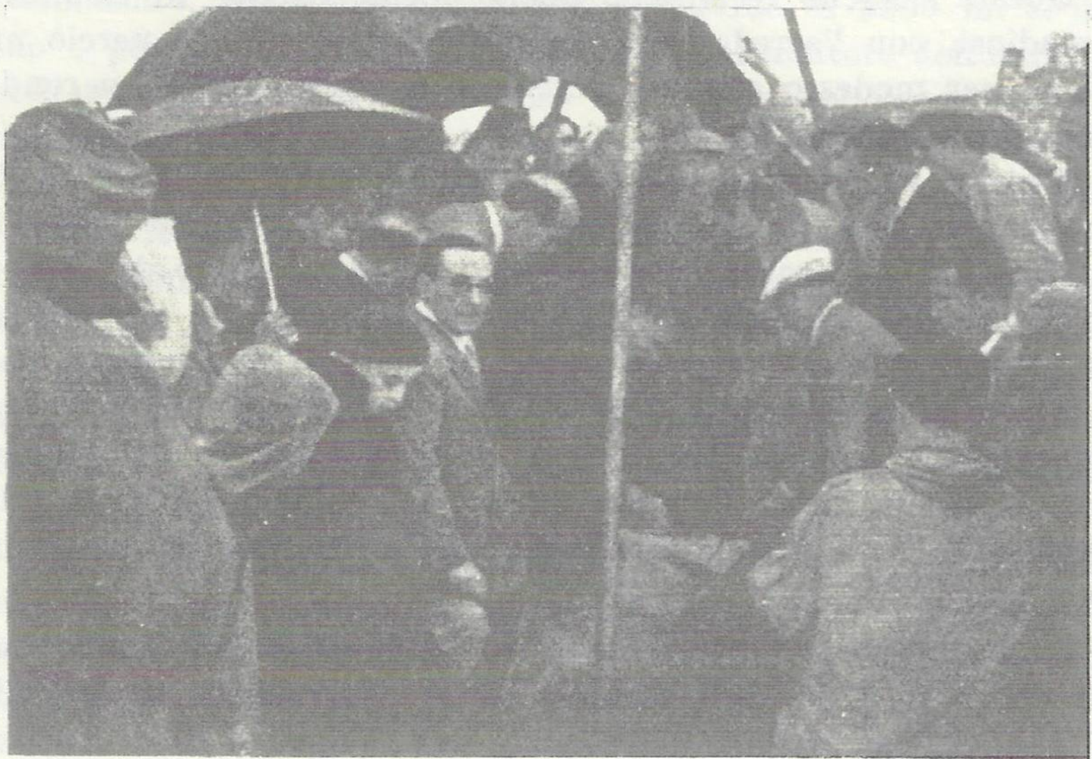
Fig. 2. — Il Prof. Frajese, rappresentante il Ministro della P.I. pone la calce ed il cemento sulla pietra angolare del lato ovest, prima che essa discenda sulla fondazione.
