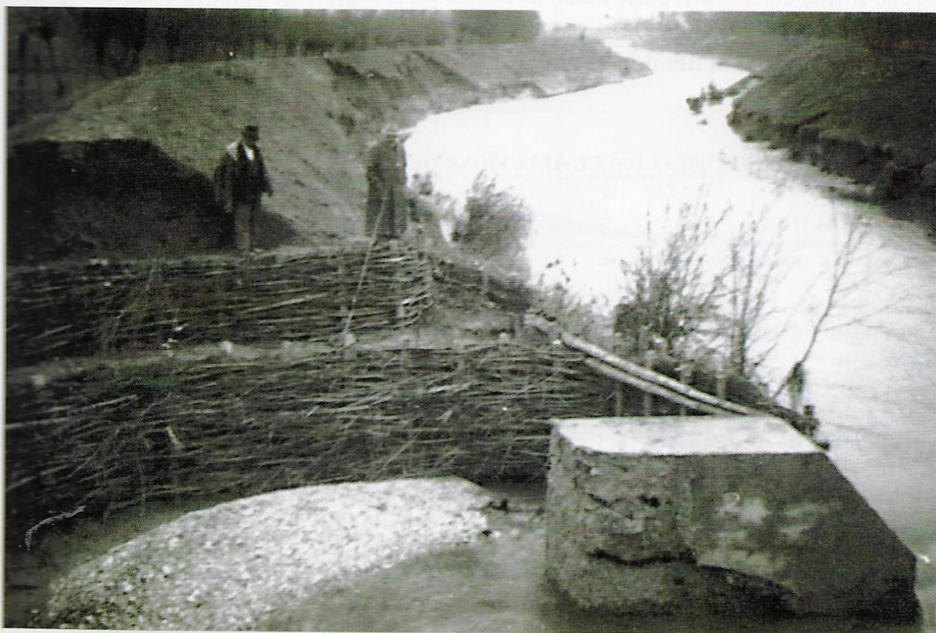
Intervento di difesa spondale con tecniche di ingegneria naturalistica – Onna 1941-1942
