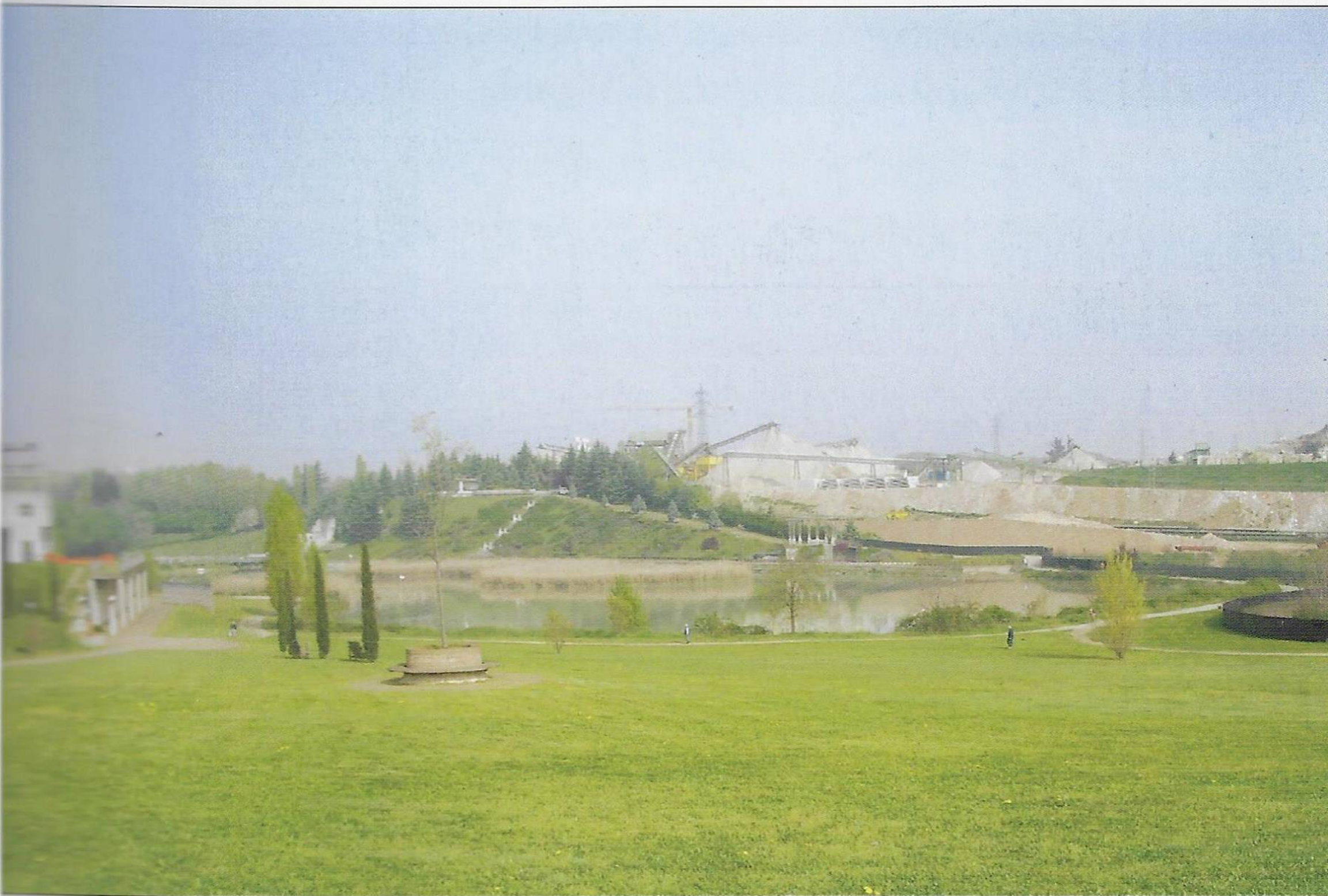
Parco Cava Nord. Il fronte cava recuperato a prato, il lago piccolo e – separata da barriere ecologiche – la cava attiva. (foto: Alberto Liberati)
