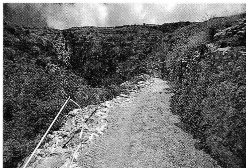
La condotta interrata.
