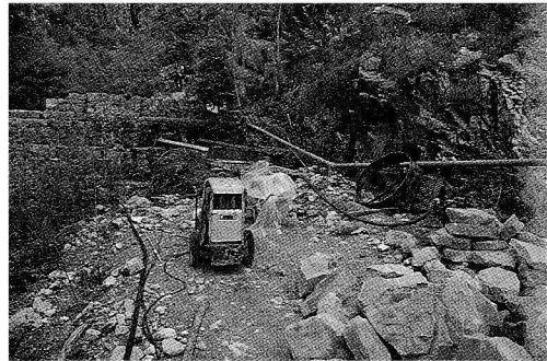
Lavori sulla prima briglia.
