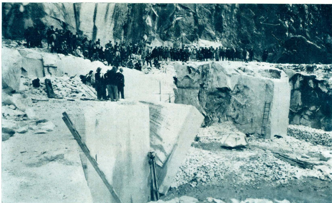
Il taglio di un blocco di marmo di duecento tonnellate, nelle Cave di Ravaccione (Carrara).
