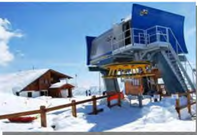
Rifugio Helios sopra Pontechianale
