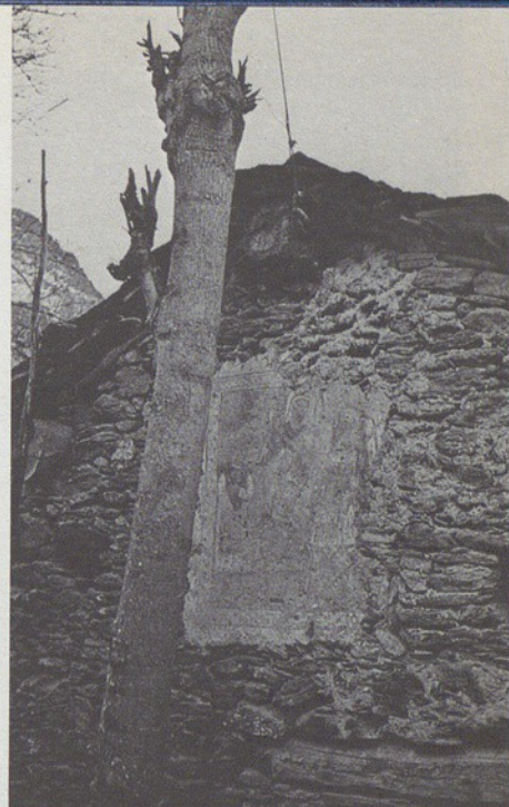
Un affresco da salvare sulla facciata di un'antica casa di Ruà, frazione disabitata ai piedi del Monte Marchion. Nella foto in basso, il delicato Cristo scolpito da peire Rous, sulla facciata della chiesa di Sancto Lucio.
