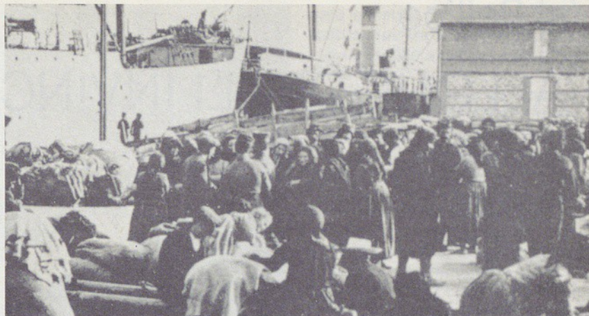
Immagine delle banchine del porto di Napoli nel 1890 (foto ricavata da: Partono i bastimenti - A. Mondadori - 1980)
