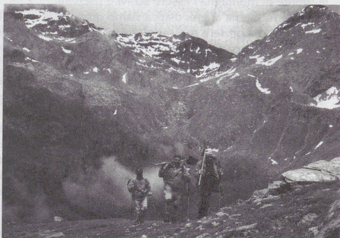
Durante i lavori di recupero del sentiero in Valle di Viù (Foto: M. Lavezzo)
