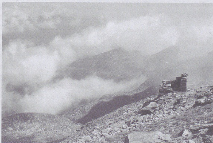
Passo del Rous, ruderi di un edificio di servizio all'osservatorio militare. (Foto: M. Brusa)
