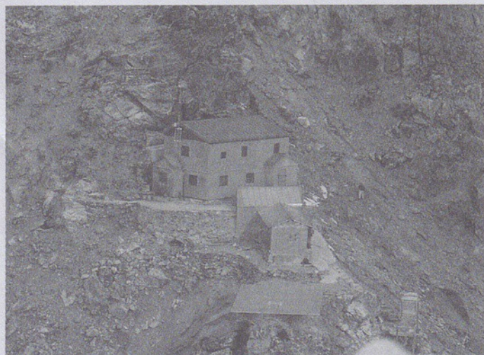
Il rif. "Gonella" ormai demolito
