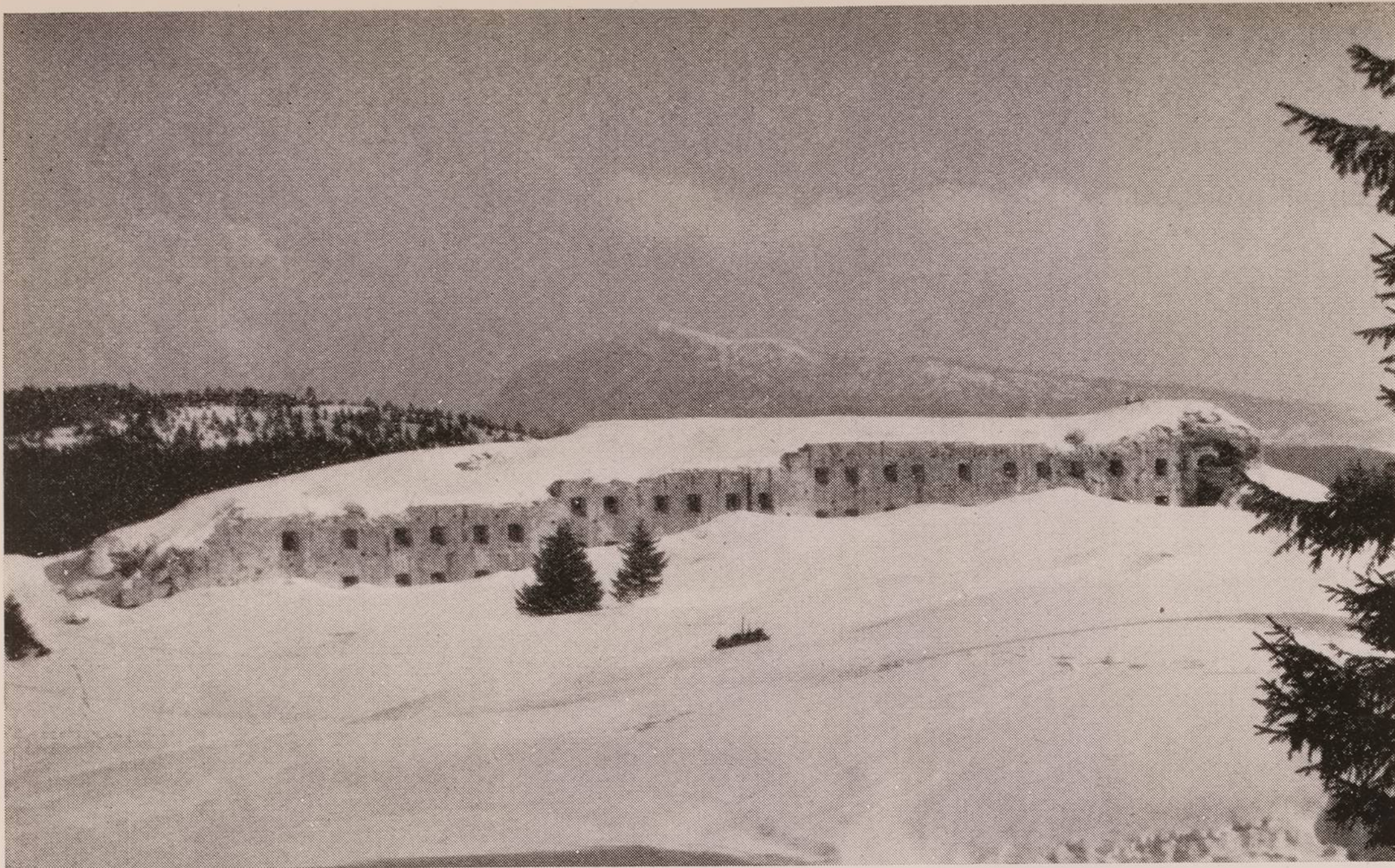
Sui luoghi della Grande Guerra, mezzo secolo dopo: i resti del forte austriaco di Verle (Altopiano di Asiago-Vèzzena); a sin. il Bosco Varagna, sullo sfondo il M. Verena. (fot. G. Pieropan, 1965)
