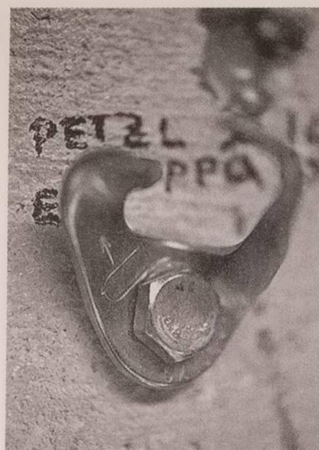
viene poi in un lasso di tempo che va dai 20 ai 60 minuti a seconda della temperatura esterna. Ad essiccazione avvenuta, si possono fissare placchetta e bullone.
