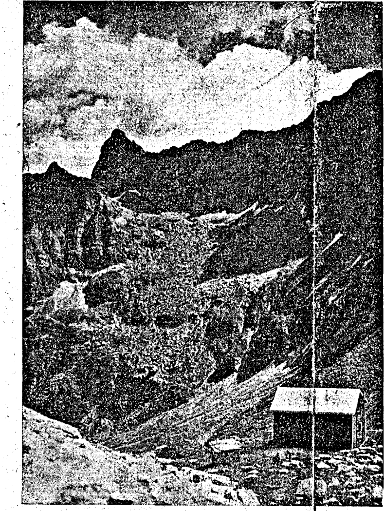
Come era il rifugio Guido Rey, ora distrutto
