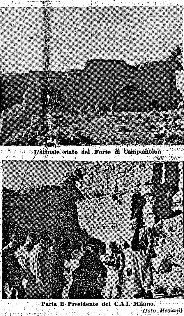
L'attuale stato del Forte di Campomolon
