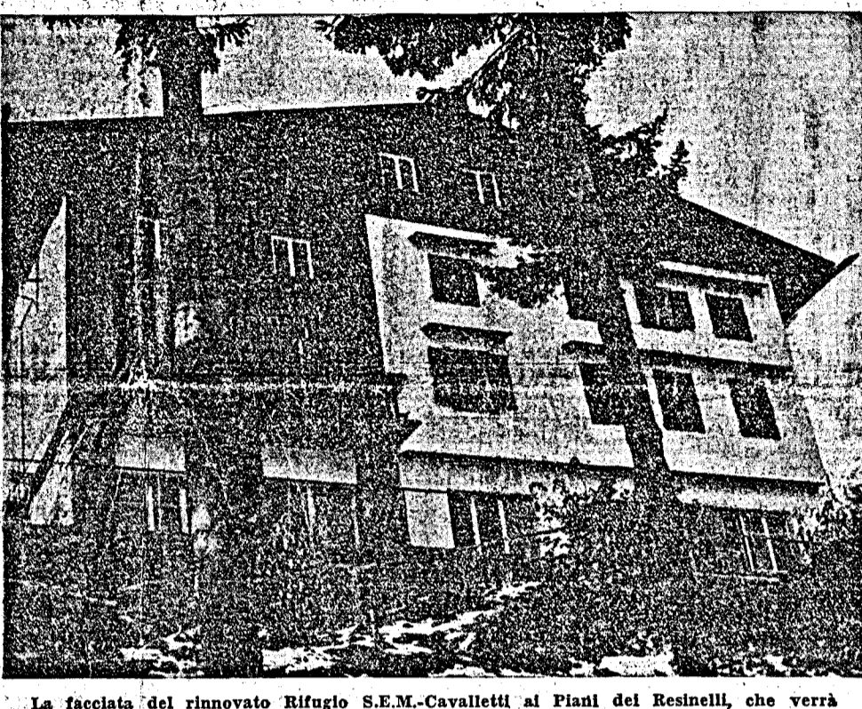
La facciata del rinnovato Rifugio S.E.M.-Cavalletti ai Piani del Resinelli, che verrà inaugurato il 25 novembre
