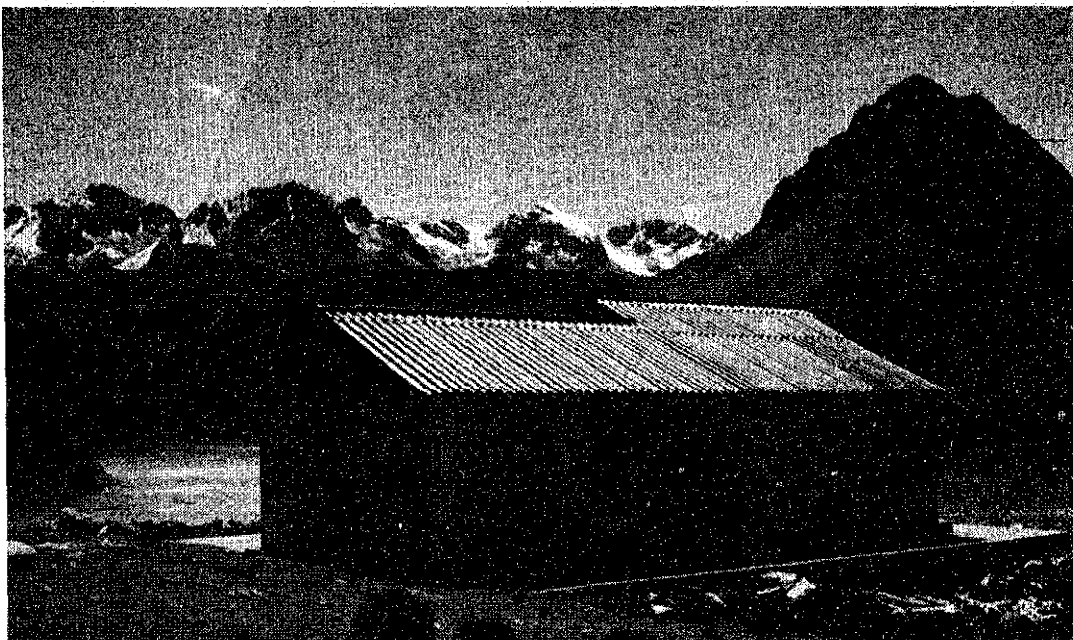
Il rifugio Kanchis a quota 4260 nell'alta valle di Santa Eulalia, nella Cordillera Central, sulle rive dell'omonimo lago Kanchis. È l'ultimo rifugio in ordine di tempo costruito da una sezione del Club Alpino Italiano (foto Celso Salvetti).
