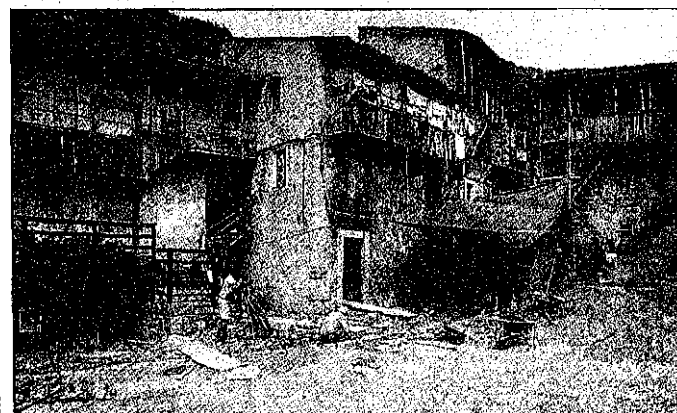
I lavori di recupero della piazzetta di Catremerio, frazione di Brembilla (BG), nell'agosto del 1992.
