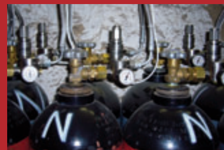
Qui sopra una brandina del rifugio sta prendendo fuoco. Sotto, un dettaglio dell'impianto di spegnimento con le bombole di azoto e il cordiale incontro tra il presidente della Commissione rifugi Samuele Manzotti (a sinistra) e il direttore generale dei Vigili del fuoco della Lombardia Dario D'Ambrosio.
