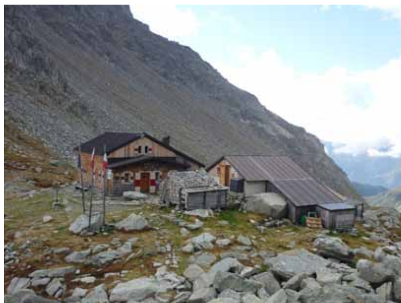
In questa pagina in alto: la simulazione grafica del progetto vincitore del nuovo rifugio Ponte Ghiaccio, nel cuore delle Alpi Aurine. Qui sopra il vecchio rifugio che sarà demolito.
