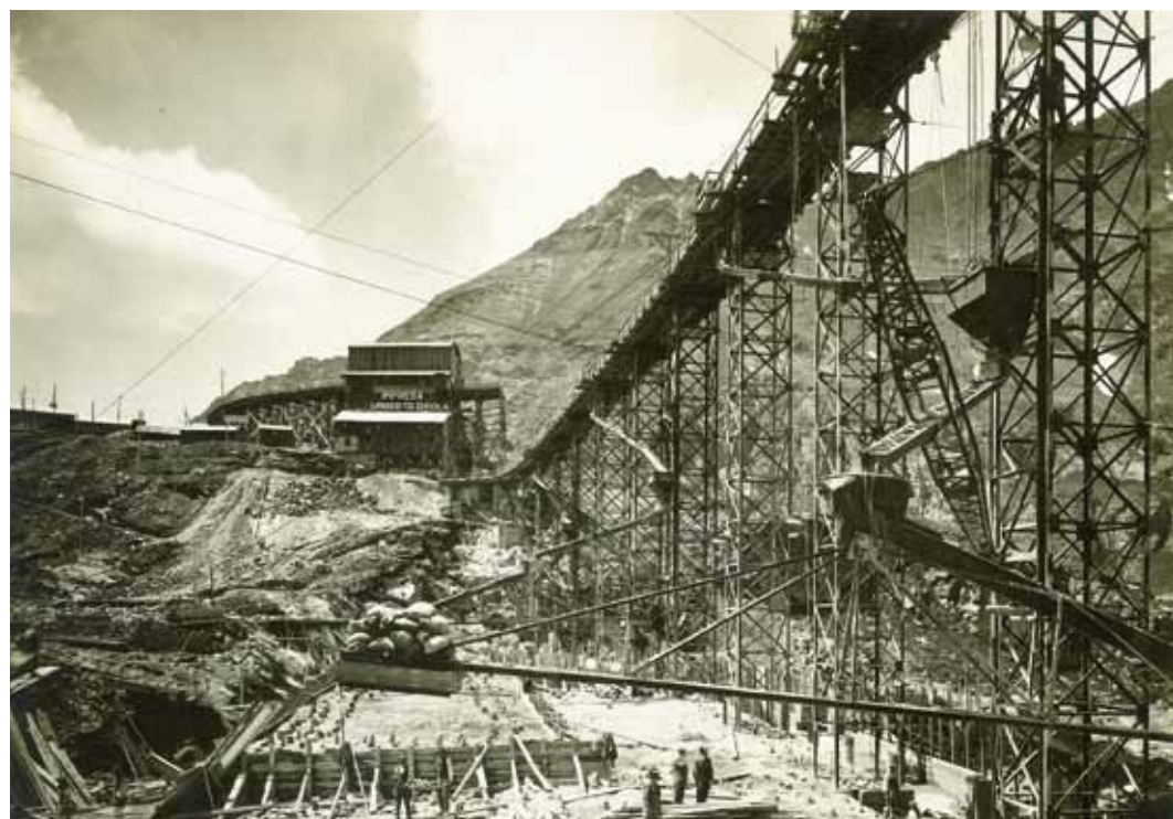
In questa pagina, in alto: Impianto di vagliatura e sollevamento, 1927, tav. 5, dall'album Impresa Umberto Girola. Diga di Cignana (Valtournenche). Impianti Marmore S.I.P. 1926-1927. Foto Antonio Paoletti. A sinistra: Pontile. Silos, 1927, tav. 4, dall'album Impresa Umberto Girola. Diga di Cignana (Valtournenche). Impianti Marmore S.I.P. 1926-1927. Foto Antonio Paoletti. A fronte: Segheria Leone Campidelli, Pelugo, 1950 ca. Foto Benini
