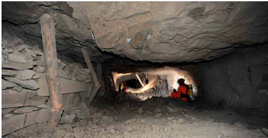
Galleria verso i Fondi Vecchi
