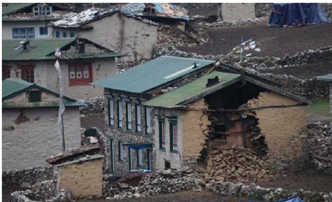
Edifici danneggiati nel villaggio di Khumjung, nella regione del Khumbu. Foto Ang Tshering Sherpa
