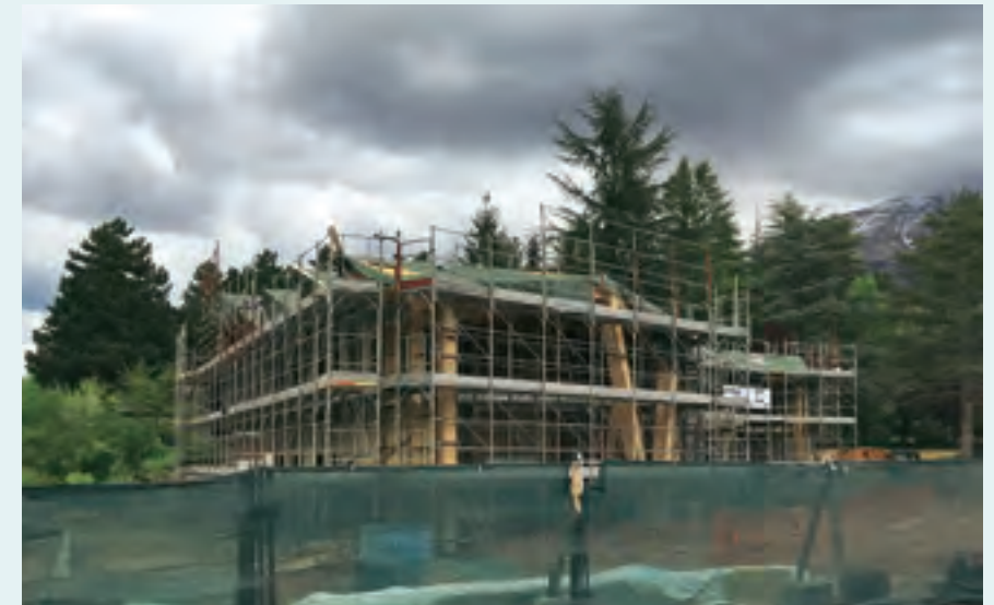
Il cantiere della Casa della Montagna lo scorso maggio
