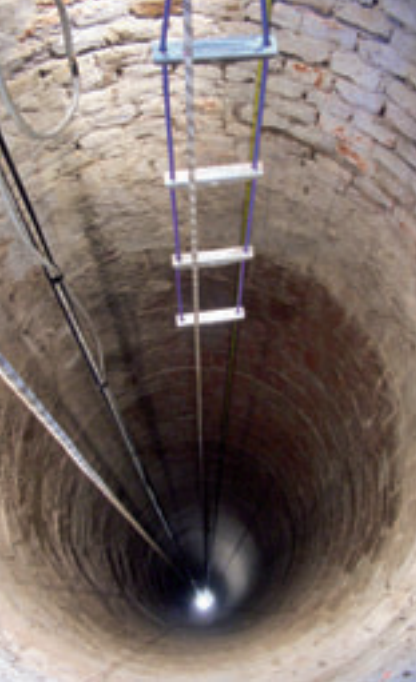
Moncrivello (Vercelli): esplorazione e rilievo del pozzo profondo 85 metri.
