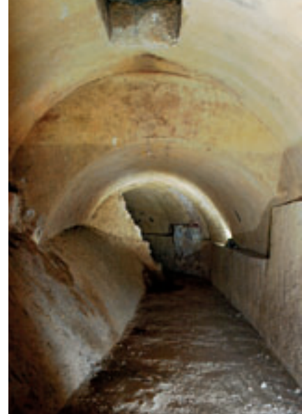
Qui sopra: Bergamo, Piazza Mercato delle Scarpe: camera di filtraggio dell'acqua piovana della grande cisterna sotterranea, e qui a sinistra, operazioni speleosubacquee per l'esplorazione e il rilevamento della grande cisterna sotterranea.
