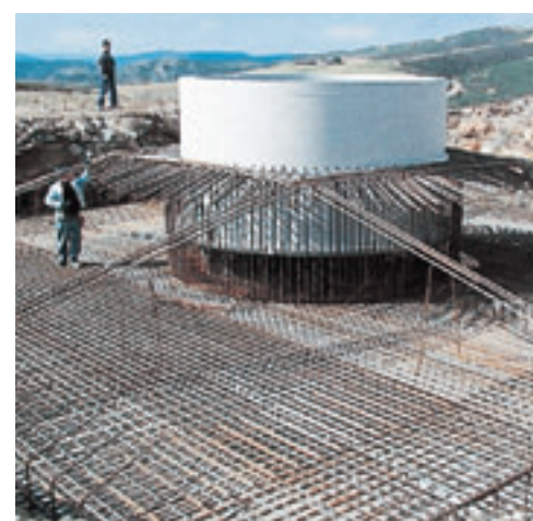
Fig. 8: Costruzione del basamento in cemento armato per aerogeneratore.
