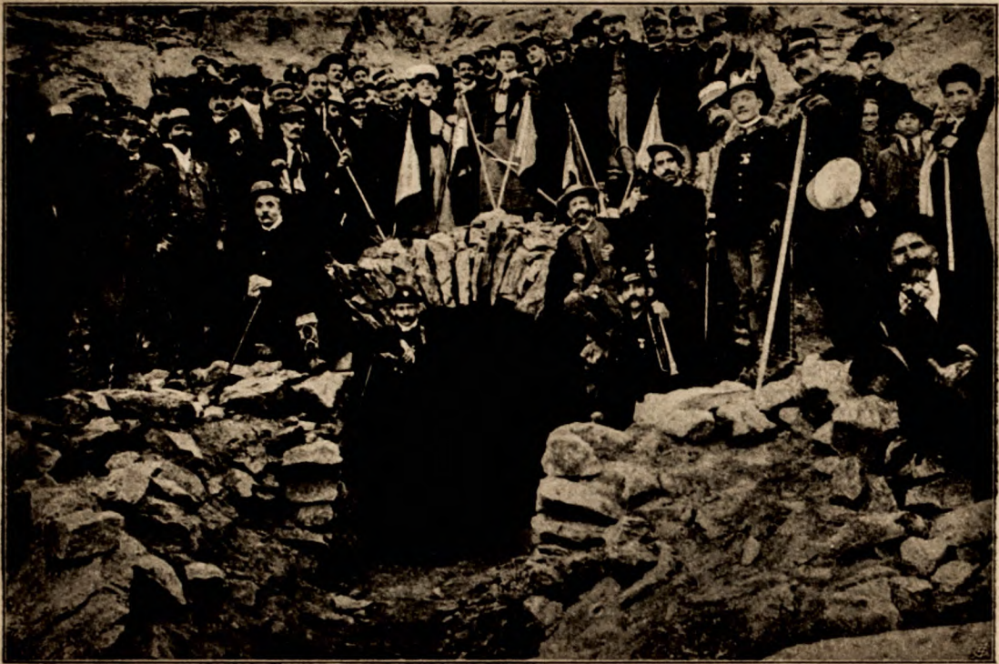
LO SBocco DELLA GALLERIA SUL VERSANTE DI FRANCIA.
