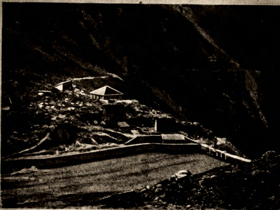
LO SBARRAMENTO E I CANTIERI AL CIGLIO D'ADAMÈ (Nello sfondo, il canale che porta l'acqua nel Lago d'Arno).
