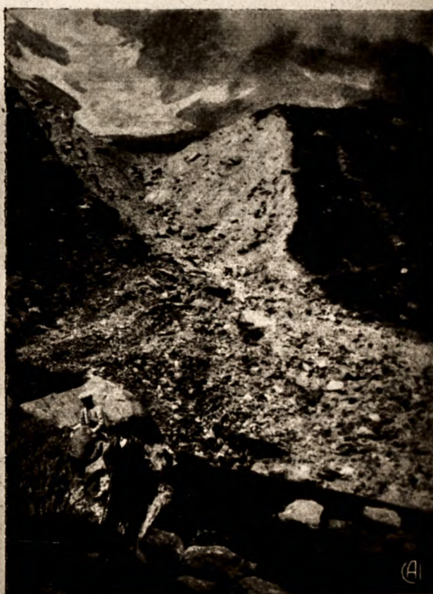
MORENA SFONDATA PRESSO L'ALPE PEDRIOLA. Veduta presa nell'agosto 1916. - Neg. dell'A.
